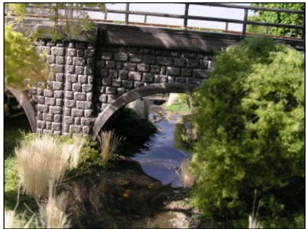
Obrázek 6 – Detailní pohled na potok pod mostem
