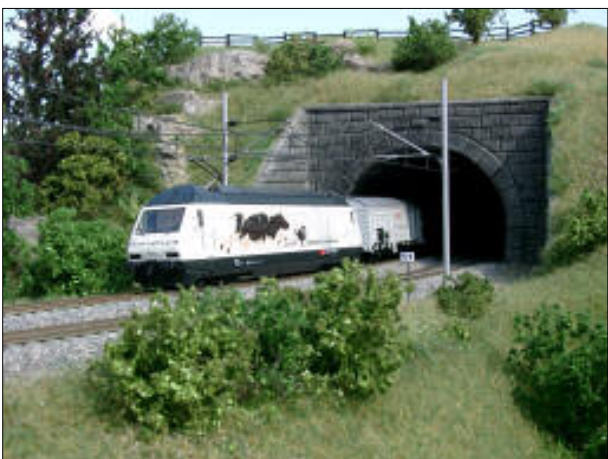
Obr.20 – Hotový 2- kolejný portál
